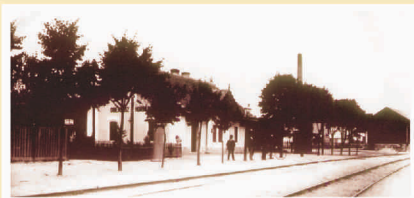
Původní nádražní budova č. 41
