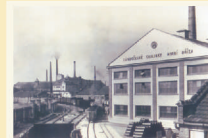
Rampa ve fliseč
