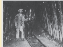
Foto nahore: dobývání kaolinu kopáním Foto nahore upravo: Plaský odklízeč 1923 Foto upravo: vnošení kaolinu vozíky taženými koněmi.
